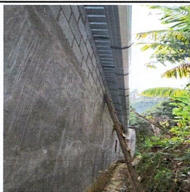
Foto 4: Finalización de bajada de agua pluvial.
