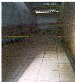
Foto1: Finalización e instalacion de piso cerámico.
