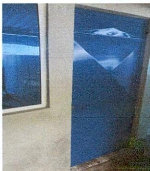
Foto 3: Finalización de instalación de puerta y ventana
