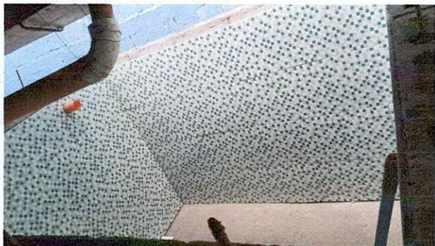
Foto1: Finalización del suministro e instalación de azulejo en el tanque de agua.
