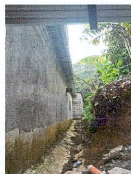
Foto: Finalización de la intalación de canales de la bajada de agua pluvial.
